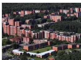
Sozialistischer Wohnungsbau im Westen? – Lüneburg-Kaltenmoor
